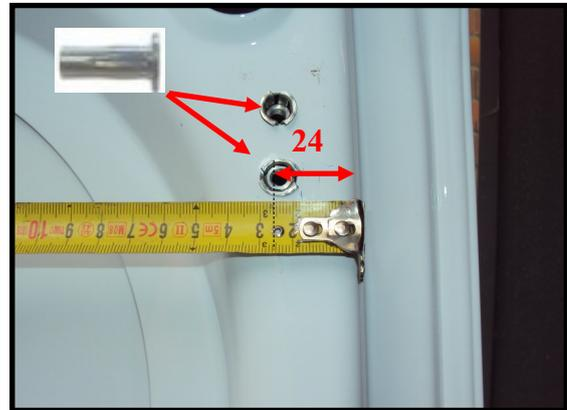
*Fixation du guide haut partie basse : Tracer, percer un trou de Ø9, puis placer un insert.*
